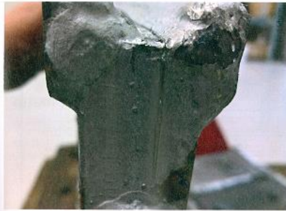
Detailaufnahme eines Risses im Bauteil (Feuerverzinkt), Ansicht von der Seite (Stirnseite).
