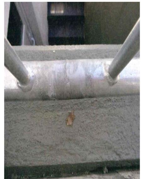
An einem verzinkten Bestandsgeländer wurden Schweißarbeiten ausgeführt und anschließend wurde die Oberfläche mit Zinkstaubbeschichtung nachgebessert.
