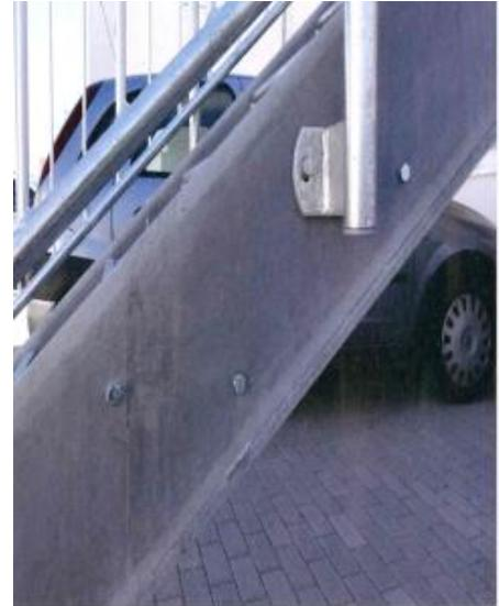
An dem Geländer und der Treppen wurden die optisch unterschiedlich verzinkten Oberflächen zwischen Treppenholern und dem Geländer bemängelt
