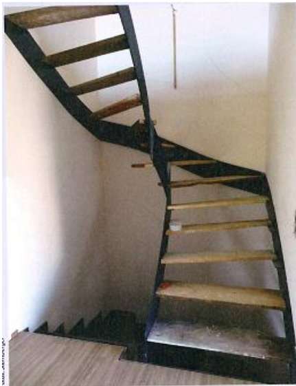
Treppe des ersten Falles. Im Einbaustadium sind des zweiten Falles. Der Kunde zeigt mit die gebogenen Treppenwangen deutlich zu sehen
