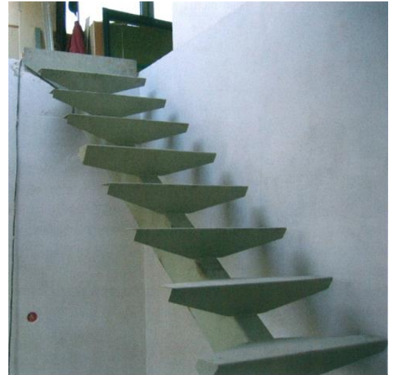
Das Geländer folgt später–Treppe im Rohbau
