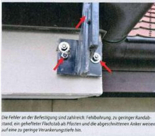
Die dilettantische Befestigung des seitlichen Geländers. Unten ein dünnes Winkelblech mit Holzschraube und auf mittlerer Höhe eine sehr ausgefallene (nicht vertrauensweckende) Variante.
