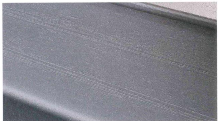
Auch auf dem Steg waren die Walzriefen zulässig, da sie nicht tiefer als 1,2 Millimeter waren.
