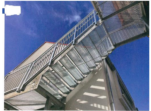
Die Fluchttreppe mit Gitterroststufen und Podesten sollte Teil des Rettungsweges für zwei benachbarte Schulgebäude sein.
